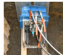
鉛管引き抜き
