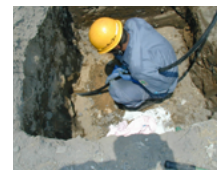
新管引き込み
