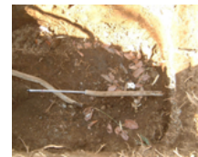
ワイヤ挿入充填材注入
