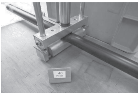
図 16 補修継手の取付確認 (1 種二層管 (PE50) 呼び径 40)
